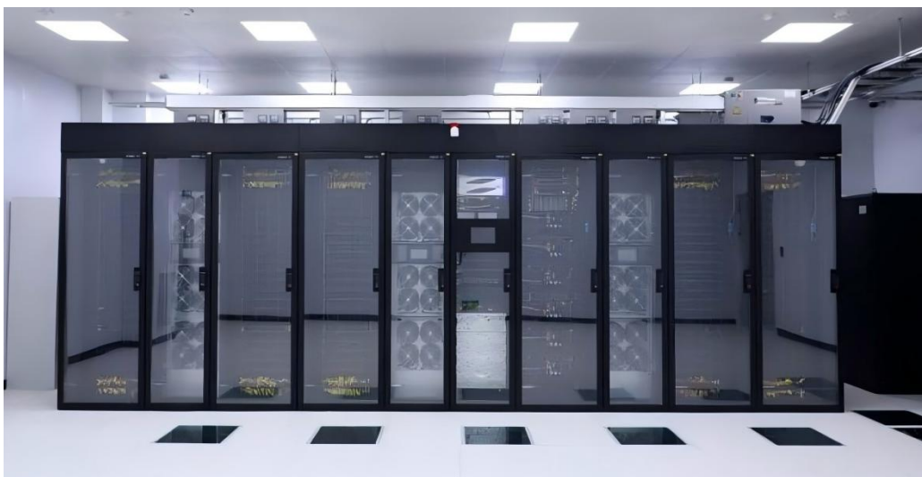
图 4：嘉庚智算中心单排液冷微模块
