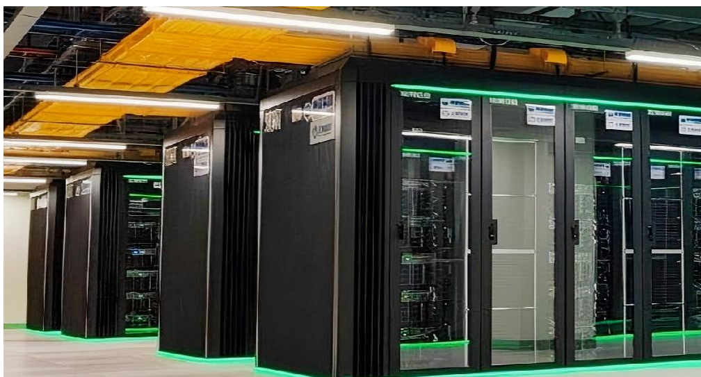
图 9：四川能投天府云数据产业基地 D1 楼 42kW 风冷高功率机柜
