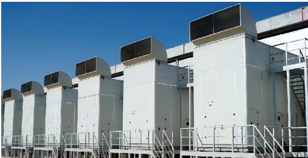
图 7: 美利云中卫数据中心 C1 数据机房楼项目间接蒸发冷却空调机组
