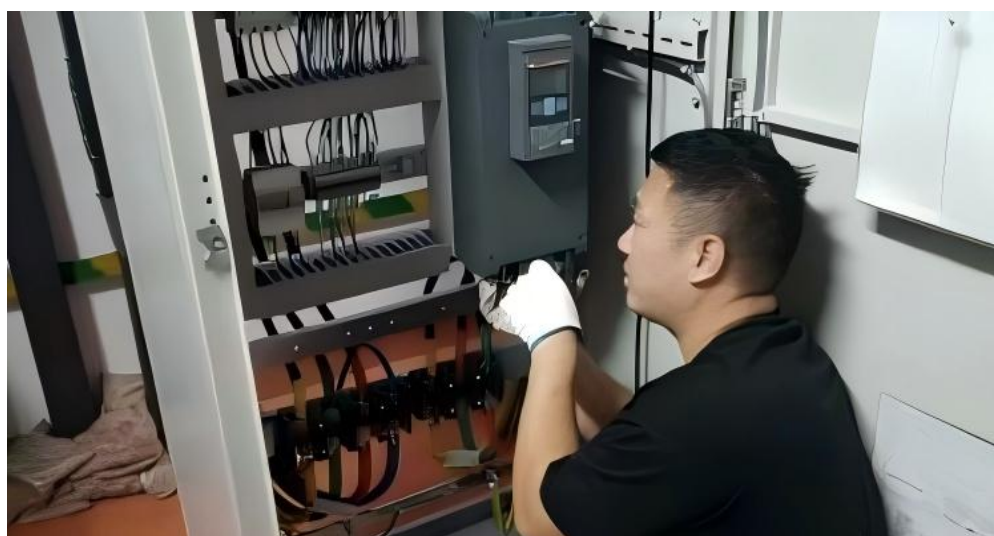
图 8: 润泽数据中心 A—8 冷冻水泵变频改造现场图
