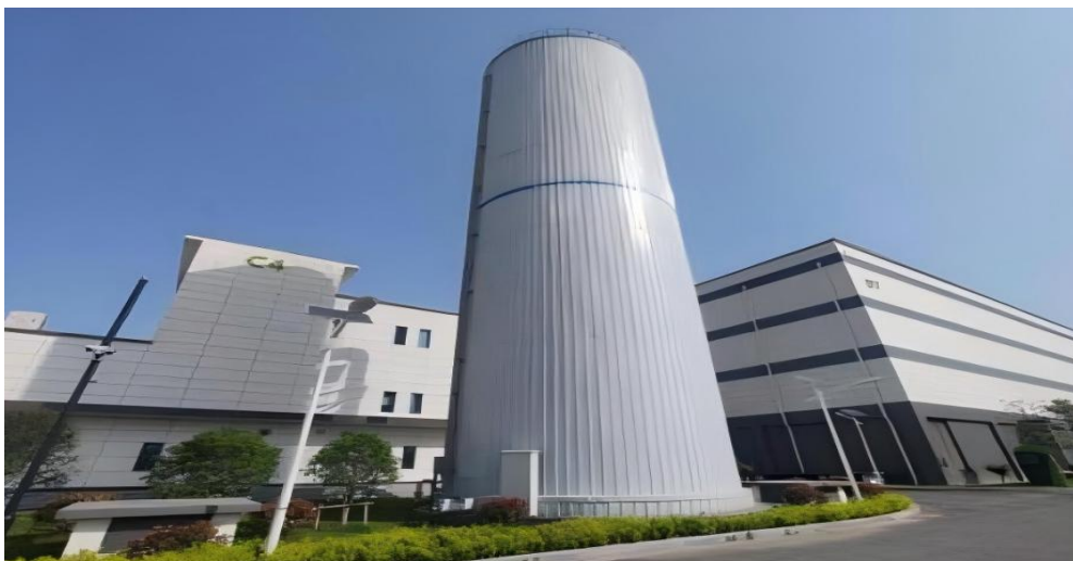
图 9：中国移动长三角（金华）数据中心 D07 楼蓄冷系统外观
