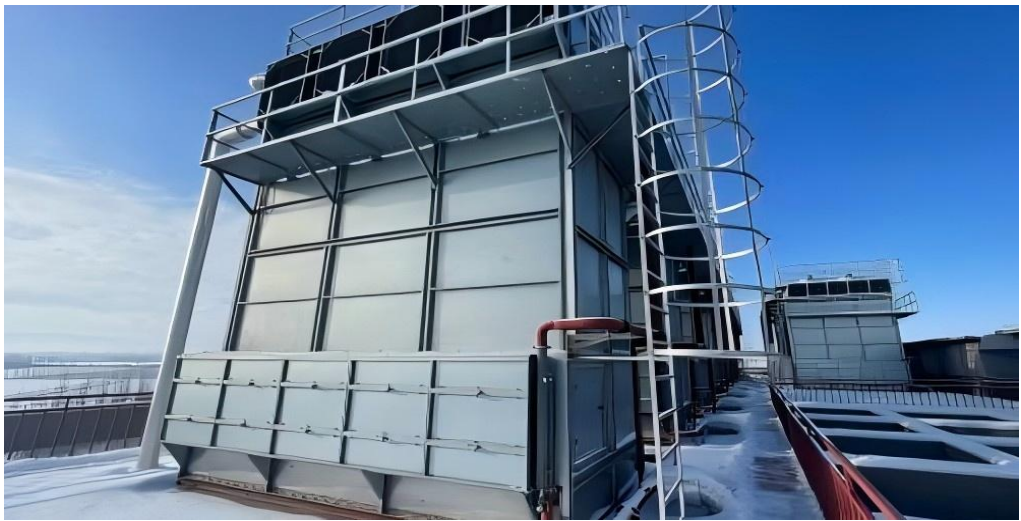
图18：中国电信昌吉云基地 4 号数据中心间接蒸发冷却冷水机组
