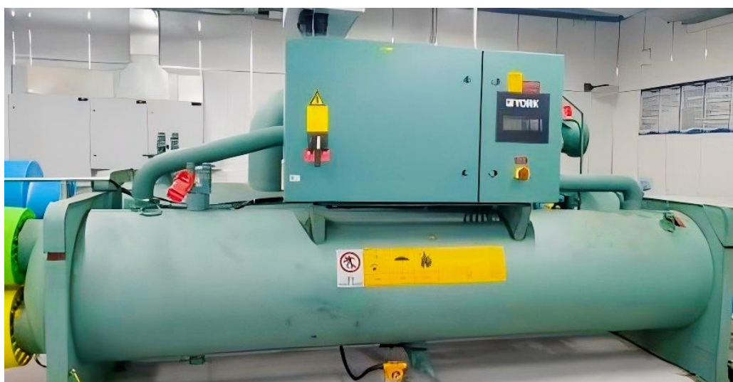
图 4：交通银行数据中心浦江园区（一期）水源热泵机组
