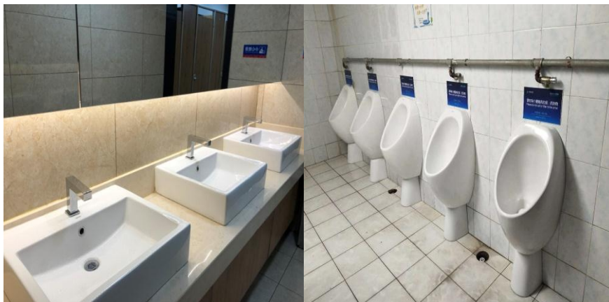
图 19: 纳米免冲洗小便池 图 20: 感应式节水龙头
