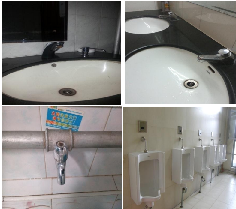
图 12: 感应、延时阀、快开等节水型器具
