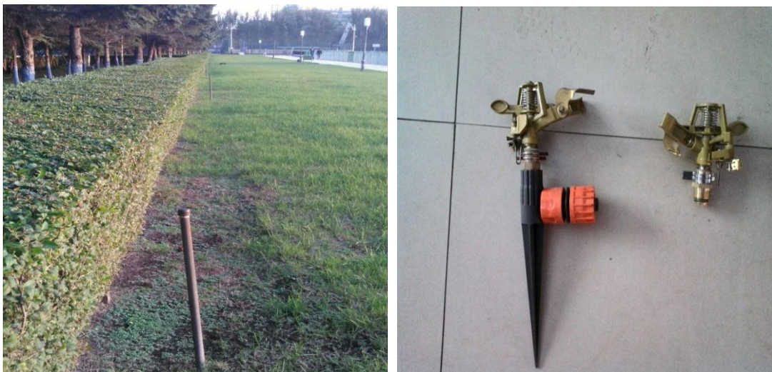
图 16: 喷灌管线、喷灌喷头
