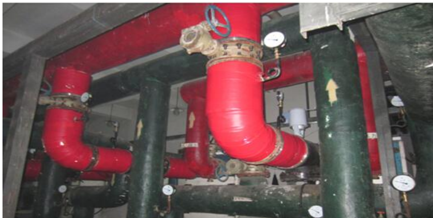
图 15：供暖管线改造
