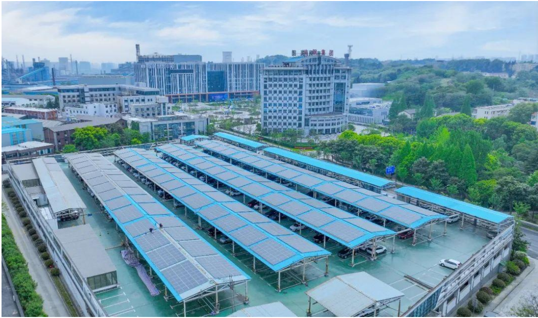
光伏发电系统
