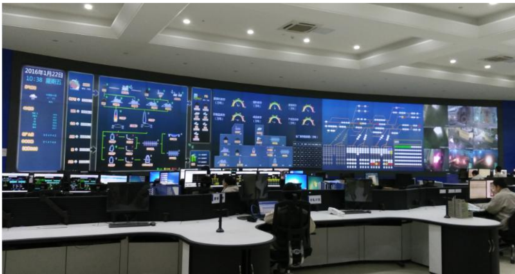
能源管控中心
