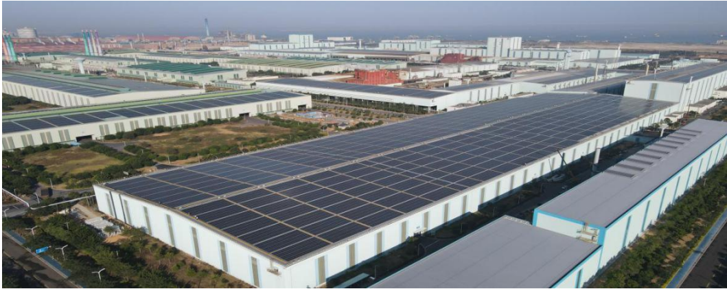
屋顶光伏发电系统
