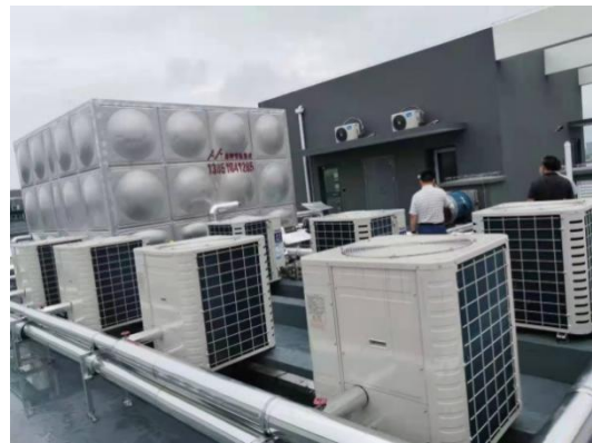
图2 改造后的空气源热泵主机
