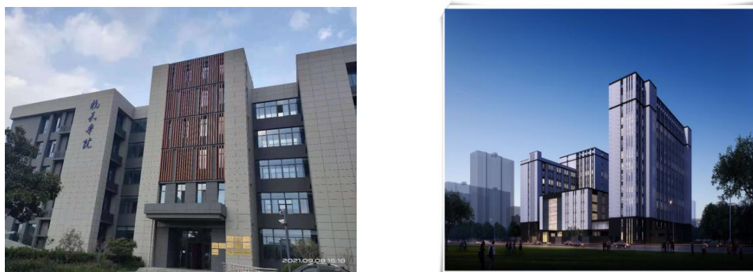
图 4 航天类学科楼及外专楼
