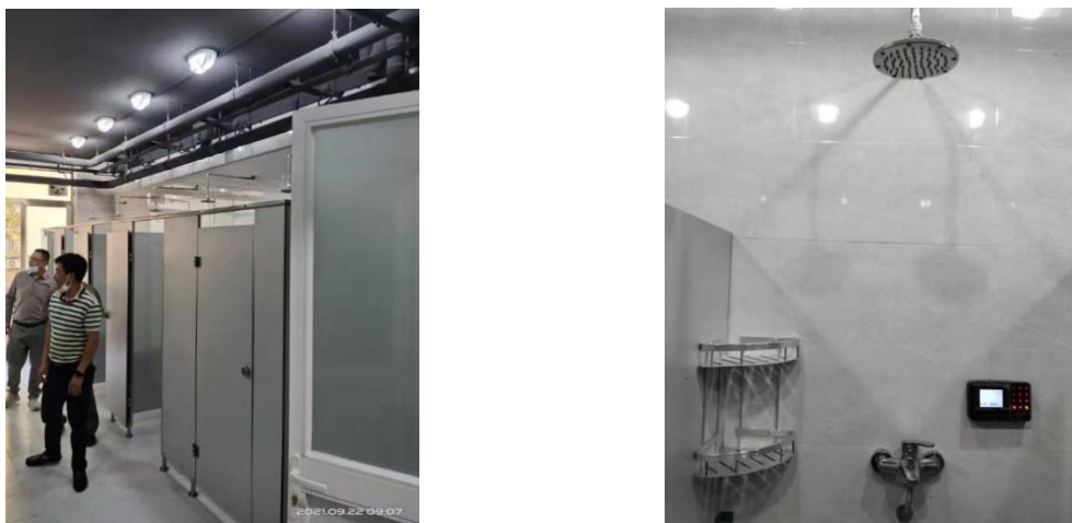
图 3 改造后的楼内淋浴间
