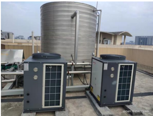
图2 改造后的空气源热泵主机
